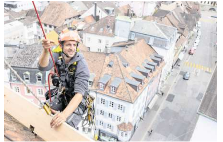
Was für ein Arbeitsplatz: Industriekletterer Thomas Schenker bei seiner Arbeit auf dem Dach des Oberturms. Bilder: Severin Bigler
